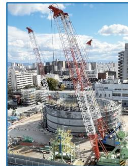
鶴見調節池の発進立坑となる城北立坑築造工事を、令和8年の完成をめざして工事を進めており現在、深さ約102mのうち約50mまで進捗しています。
