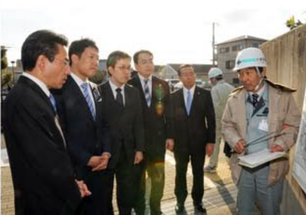
耐震化工事を実施している寝屋川市内の安全橋、 【南前川高架橋】(工事予定)の視察
