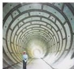
北部地下河川内部
